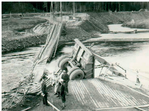
Hängbron vid Järkvissle kraftstation har kollapsat lördagen den 25 oktober 1958. De viktigaste cheferna vid kraftverksbygget överlägger. I mitten med ljus överrock står högste chefen Oskar Rinne. Bilden är tagen från norra sidan älven.
