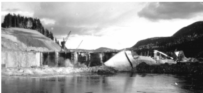
Järkvissle kraftstation i ett tidigt byggnadsskede. Uppdämningen hade ännu inte påbörjats. Kraftstationen byggdes, enligt officiella uppgifter, under åren 1954-1959. Foto: Arne Johansson.
