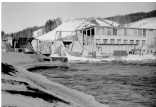
Järkvissle kraftstation under byggnad. Högt ovanför skymtar tjänstemannamässen. Foto: Paul Nilsson.
