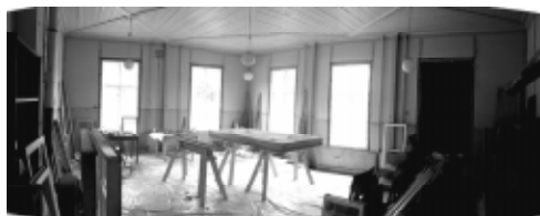
Den adresserade fönsterkarmen för pågående renovering, i skolsalen i Åsens gamla skola.
