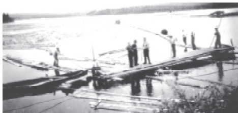
Flottare i arbete vid Oxsjödammen. Varpbåten ligger bakom och trycker på, svag motvind.
