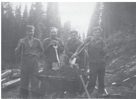
Vägbygge i Västanå 1930-tale
